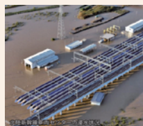
北陸新幹線の水没状況 令和元年東日本台風、北陸 地方整備局管内の被害記録 より
